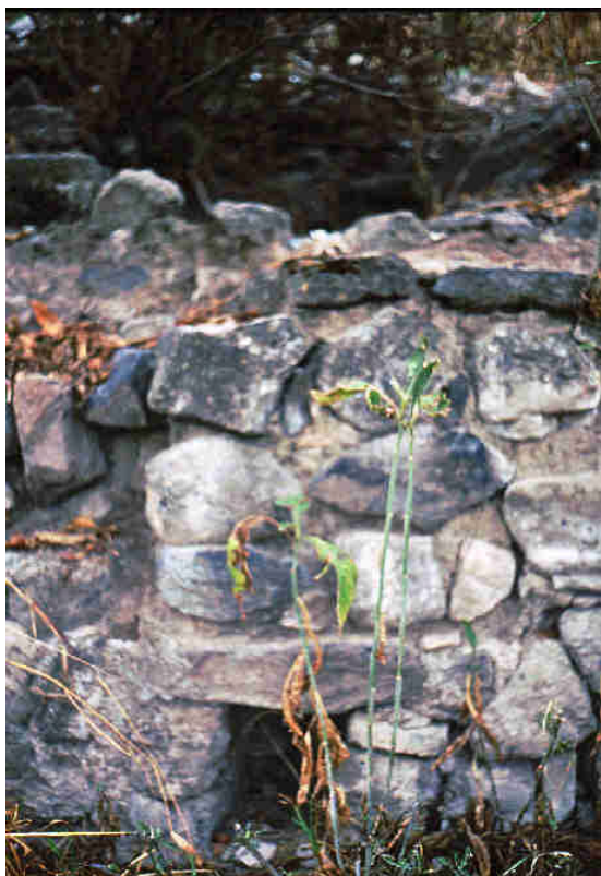
Restos de la antigua toma del agua que atravesaba por el solar de Martín de Garay. Foto Alberdi, 2002.
