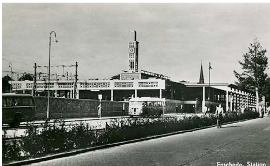
Boven: Station Enschede: systeembouw van ge-recyclede, geprefabriceerde betonelementen, met als monumentale blikvanger de klokkentoren die eigenlijk een omklede schoorsteen is (prentbriefkaart, 1950/1951, collectie auteur). Onder: Interieur station Enschede (bron: Katholieke Illustratie, 6 maart 1954)
