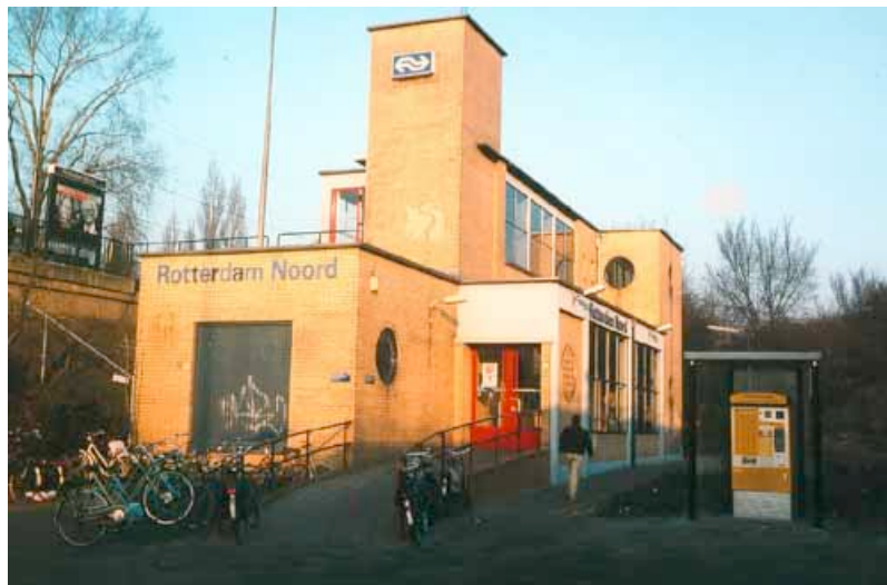
Het in kubistische vormtaal uitgevoerde station Rotterdam Noord in 1998 - foto Victor Lansink
