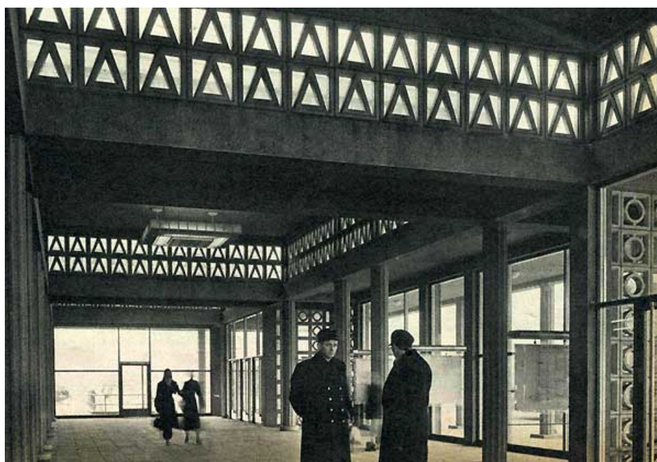
Boven: Station Enschede: systeembouw van ge-recyclede, geprefabriceerde betonelementen, met als monumentale blikvanger de klokkentoren die eigenlijk een omklede schoorsteen is (prentbriefkaart, 1950/1951, collectie auteur). Onder: Interieur station Enschede (bron: Katholieke Illustratie, 6 maart 1954)
