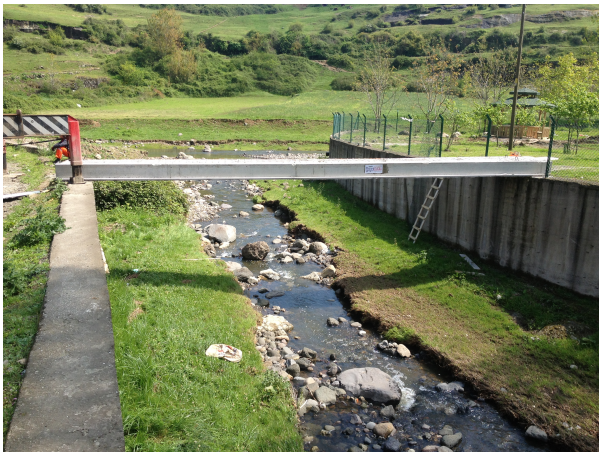
TEKKEKÖY MAĞRALARI YAYA KÖPRÜSÜ L = 1250 E=240 Kalınlık 30cm.
