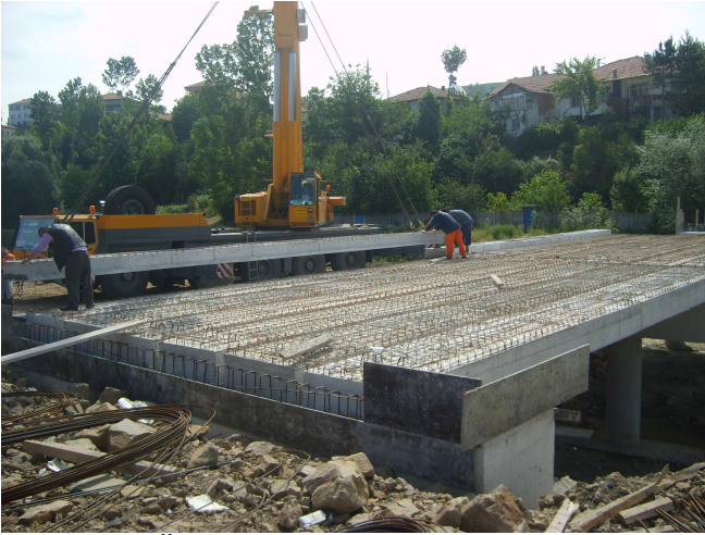
Yaya yolu Öngerilmeli Prekast elemanın montajı
