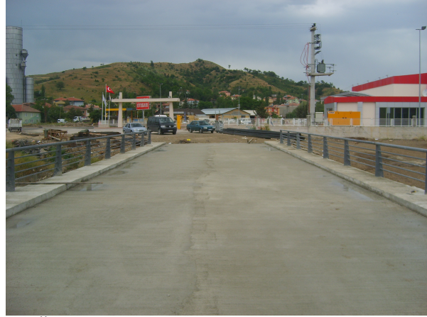
Üst Betonlama tamamlanmış
