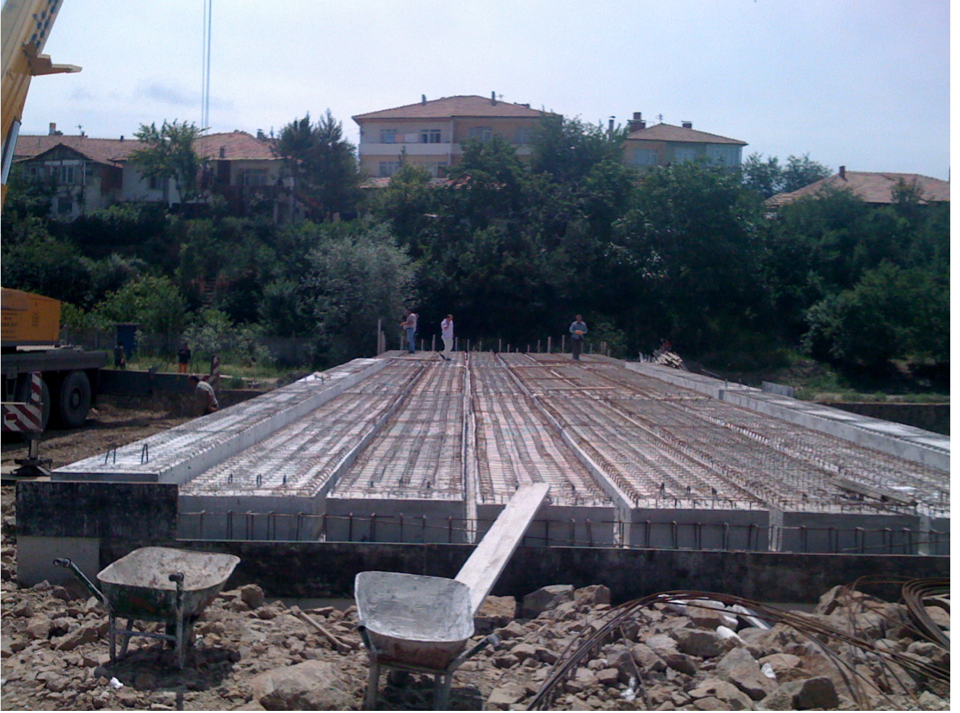
Montajı Tamamlanmış Tabliye Sistemi
