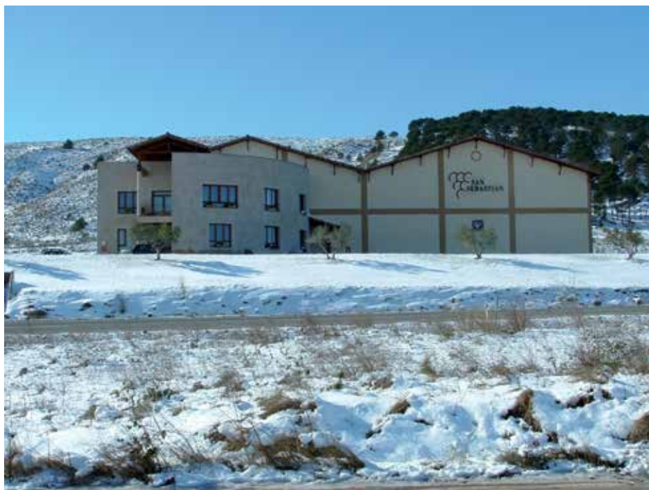
Instalaciones de la bodega cooperativa San Sebastián de Andosilla. (Fot.: Puskas, www.andosilla.net ).
