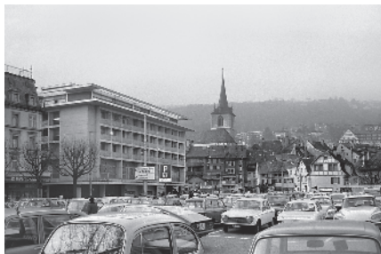
12 Marché-Neuf, bât. commercial démol
