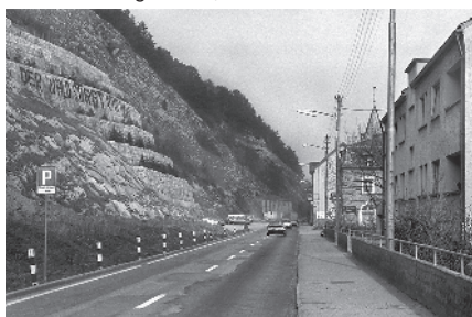
74 Vigneules, route de Neuchâtel
