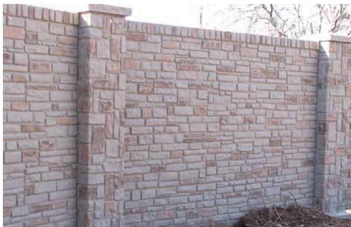
Kuva 6. Makrokuiduilla vahvistettu betoninen kuvioitu aita.
