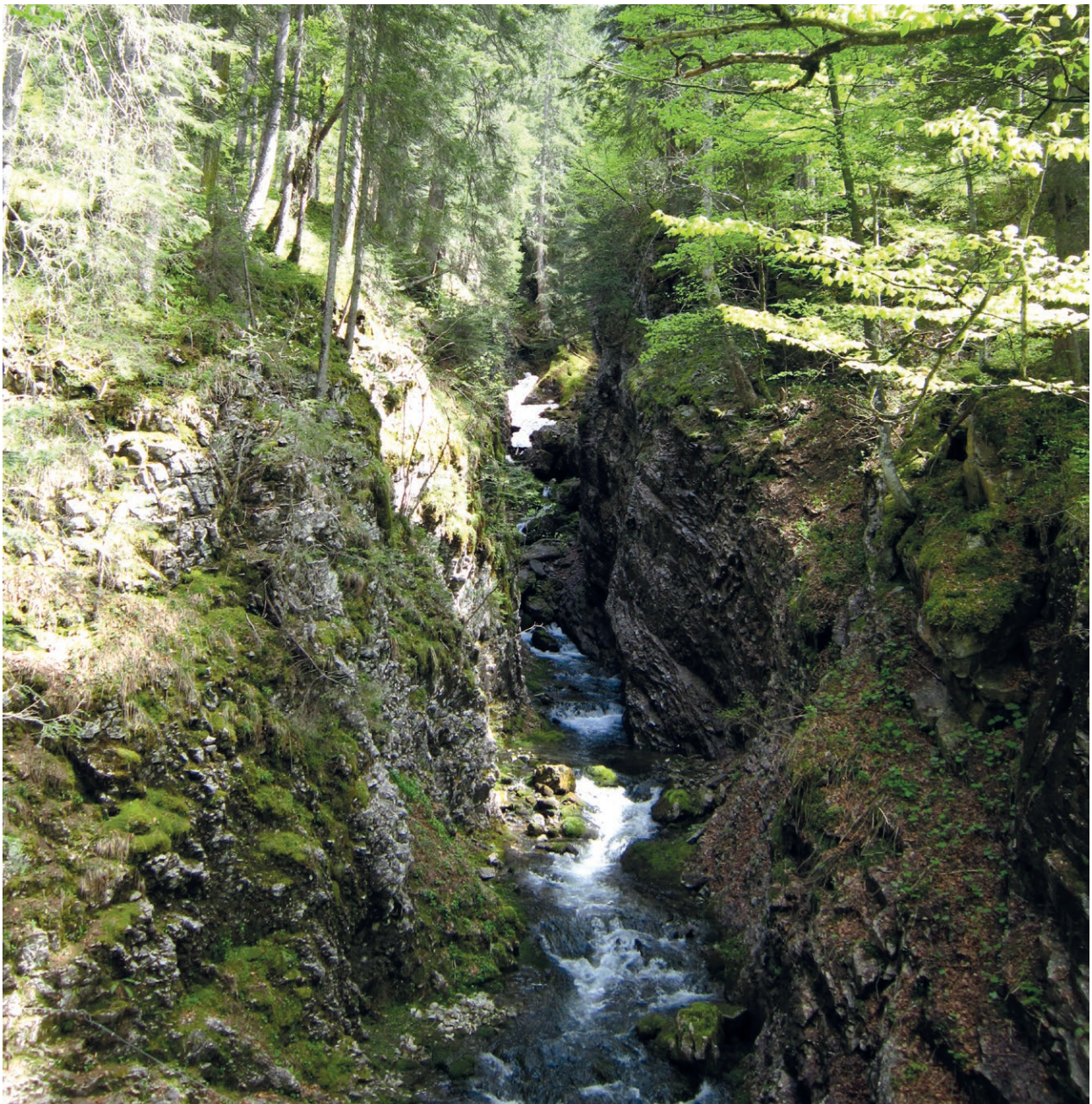
Eingestürzte Schluchtstrecke entlang des Laublisbaches (Bauer o.J.)
