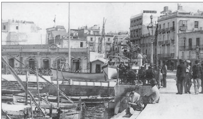
Vista parcial del puerto de Cartagena (h. 1920).
