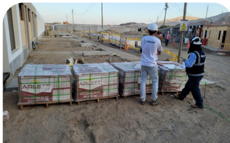
OBRA PARQUES DE HUACACHINA ICA - ICA
