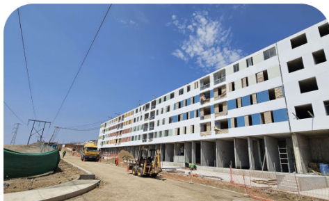
OBRA SAN ANTONIO DE MALA MALA - CAÑETE
