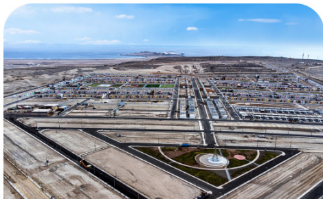
OBRA VILLA PRIMAVERA ILO - MOQUEGUA
