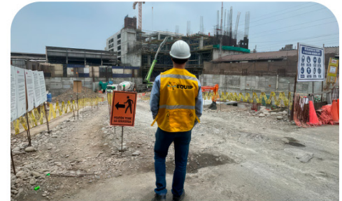
OBRA CENTRAL PLAZA SANTA ANITA - LIMA
