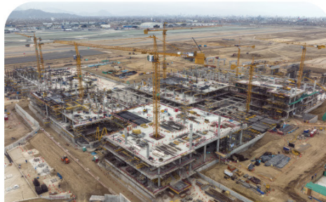
OBRA AEROPUERTO JORGE CHÁVEZ - LIMA
