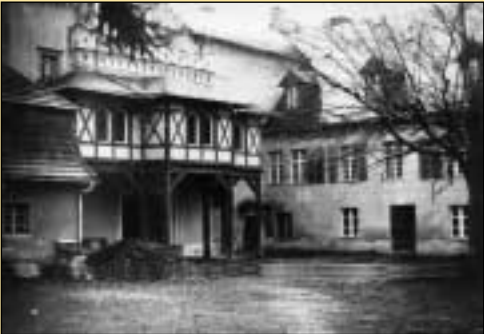
Neu Hof, Ansicht des Innenhofs Radociny, widok dziedzińca od wewnątrz
