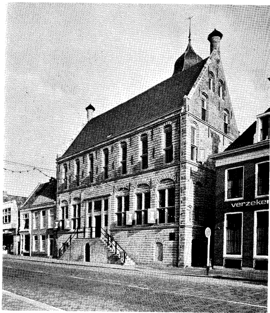
Martenastate te Franeker na de restauratie van 1972
