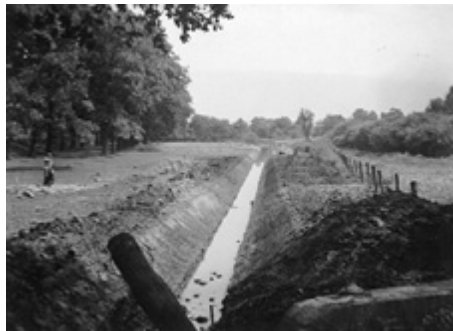
Naturferner Ausbau des Königsbachs in den 1930er Jahren
