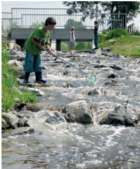
2006 hat der Netteverband unterhalb des Windmühlenbruchs anstelle der alten Stauanlage eine naturnah gestaltete Sohlrampe errichtet, die sich bei spielenden Kindern großer Beliebtheit erfreut
