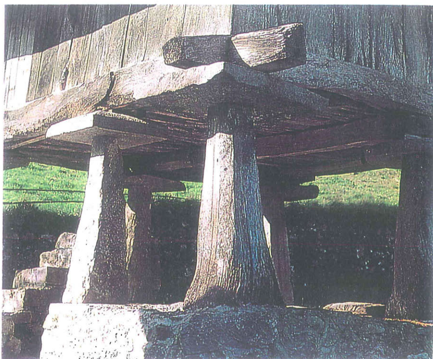
Detalle de 'pegollos' de madera. Zona central.
