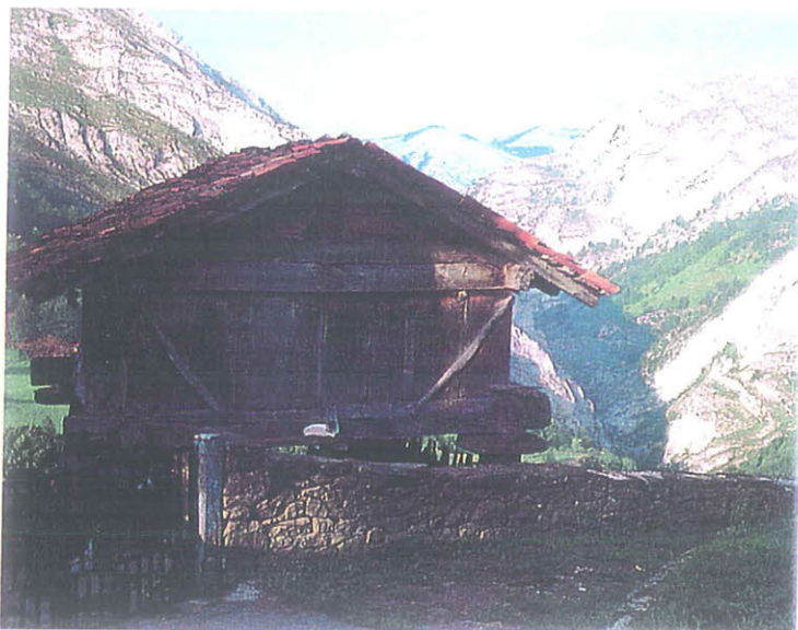
Hórreo con cubierta a dos aguas. Viego (Ponga).
