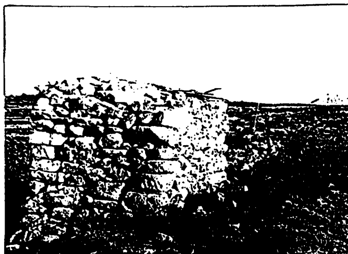
Foto 4 - El Raido. Uno de los chozos -construidos, tal vez, con piedras de la calzada- que jalonan el itinerario.
