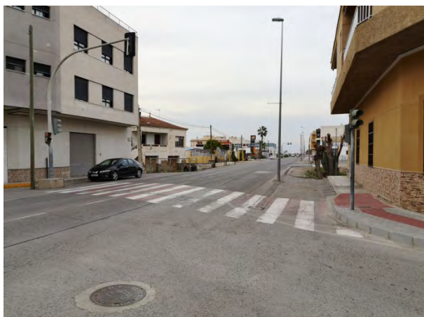
Foto 15. Cruce peatonal en la Avda. de Crevillente, intersección con la calle Juan XXIII
