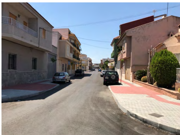
Foto 19. Calle Comandante Víctor. Con aceras anchas y sobrecanchos en las intersecciones.
