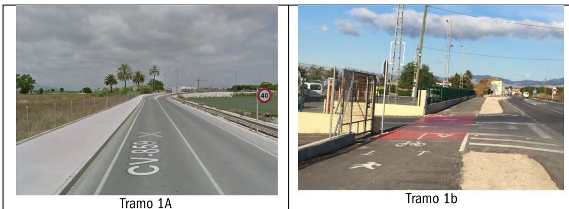
Foto 25: Sección tipo de la vía ciclista de la carretera CV-859 (tramo consolidado)
