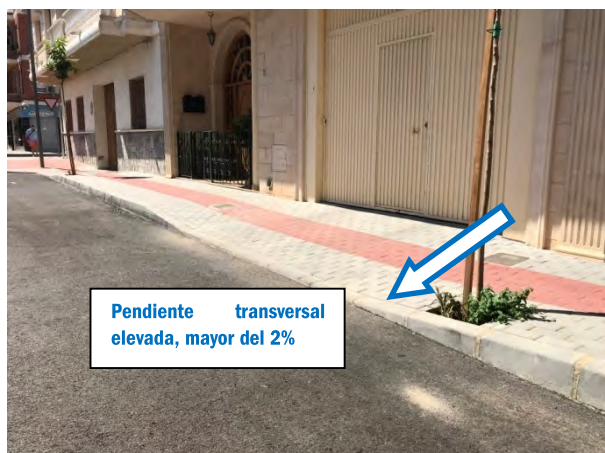
Foto 20. Aceras con exceso de pendiente transversal y longitudinal
