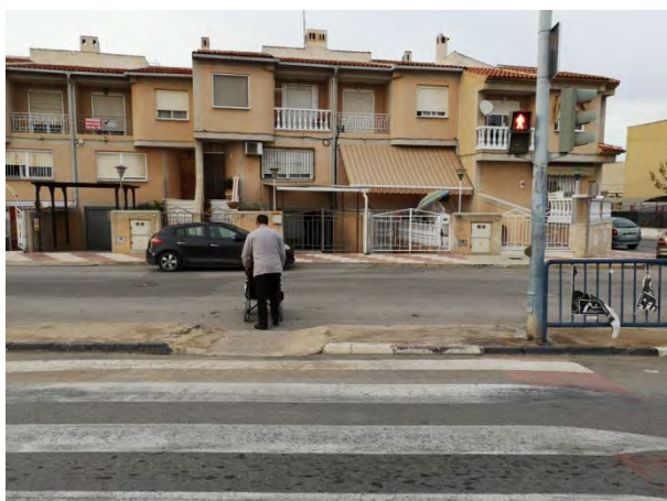
Foto 12. Cruce de la CV-855 junto a la Avda. Príncipe de Asturias. Paso peatonal sin continuidad
