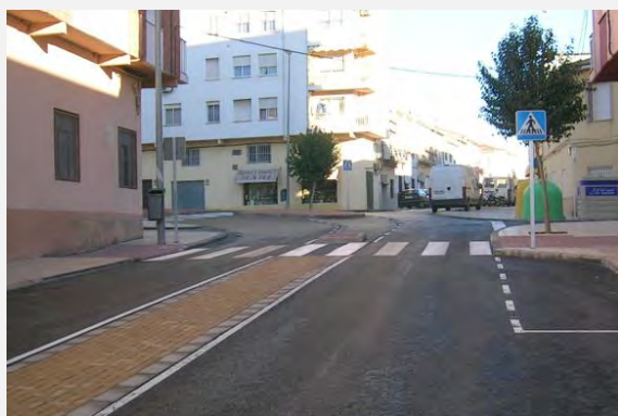
Mediana pisable. En las vías colectoras para disminuir el ancho de los carriles y permitir un refugio peatonal en los pasos peatonales.
