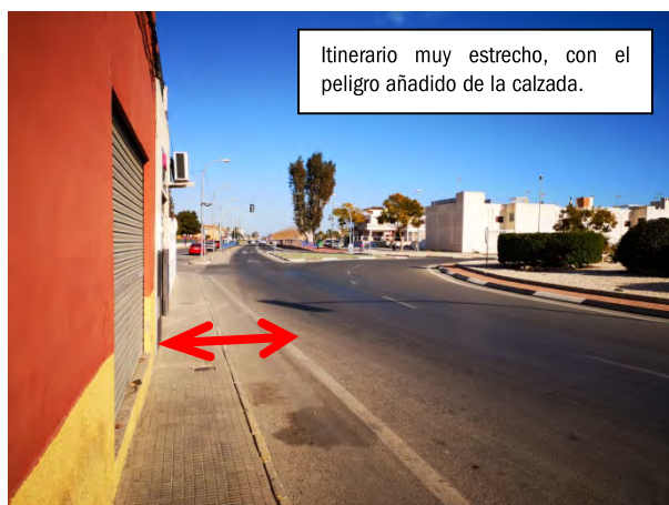
Foto 9. Acera estrecha en el itinerario peatonal de la CV-855
