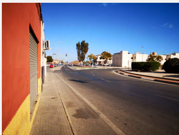
Ampliación de acera en tramo situado entre las calles San Isidro y Labradores, junto a la rotonda.
