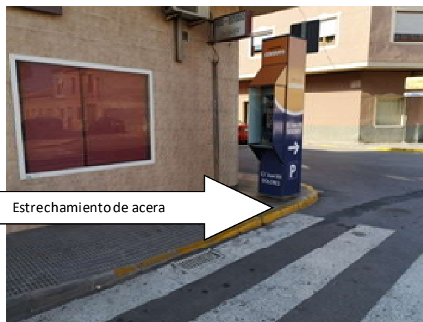
Foto 11. Estrechamiento de acera por presencia de mobiliario urbano
