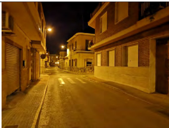
Calle de la Unión (iluminación sodio).
