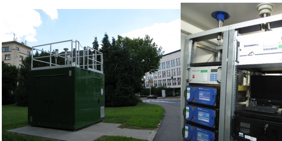
Station de surveillance de la qualité de l'air et points de prélèvement (appareils bleus sur la photo de droite)
