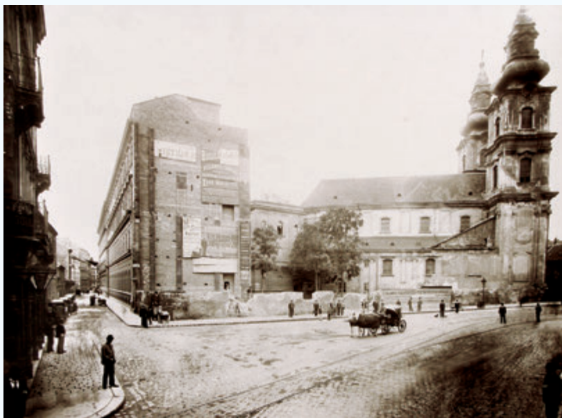
1 Az Egyetem tér a régi központi épület lebontása után University square after the demolition of the old main building
