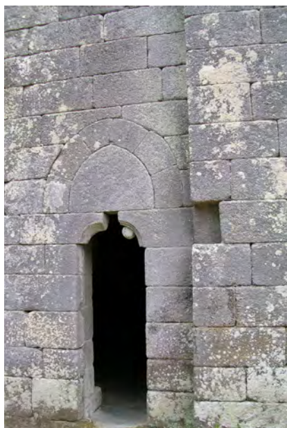
Puerta de ingreso al templo desde el flanco Norte
