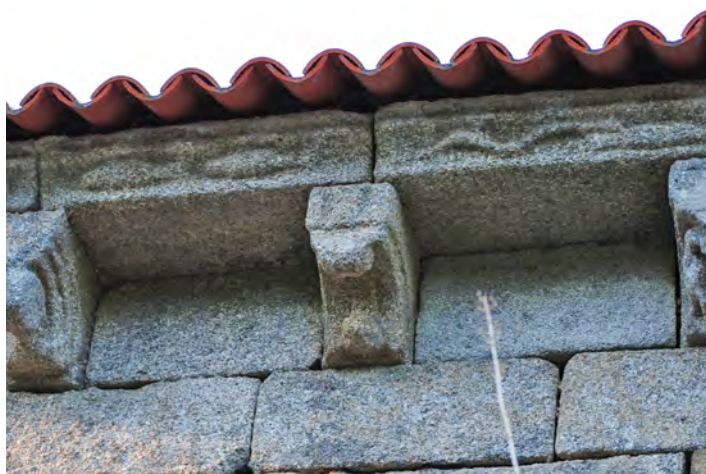
Detalle del alero y canecillos del lienzo sur de la nave
