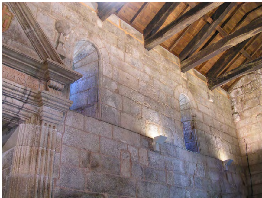
Paramento sur del interior de la nave.
