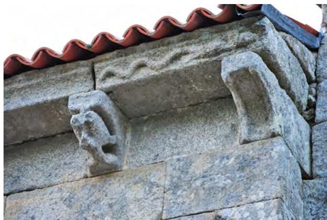
Detalle del alero y canecillos del lienzo sur de la nave
