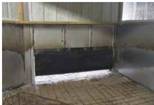
ゴム製のフラップゲート：コンベヤーベルトから作られた柔軟性のあるカーテンを組み合わせた縦型スライドゲートは、誤って豚を挟んでも怪我をさせることがない。トラック上でスライドするフレームがカーテンの上でどのようにボルト止めされているかにも注意すること。
