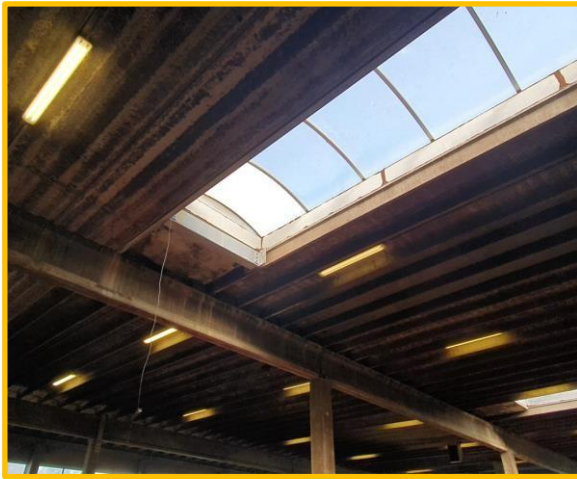
天窓は温度を急激に上昇させる恐れがある
