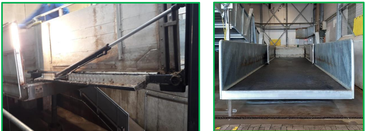
傾斜を最小限に抑えるため、高さが調整できるスロープ
