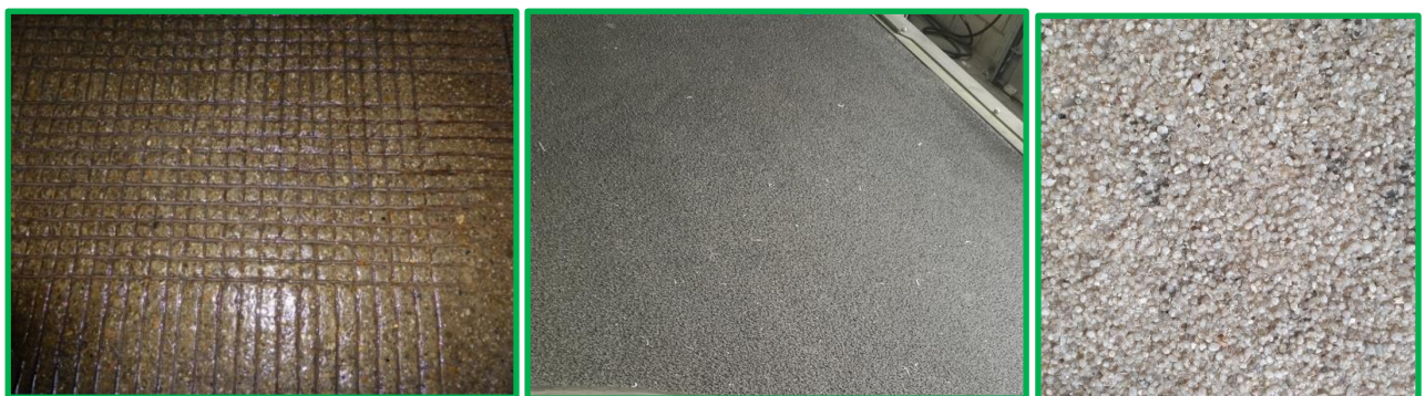
積み下ろし場の床の滑り止め Berdexのスロープの滑り止め Finklのスロープの滑り止め
