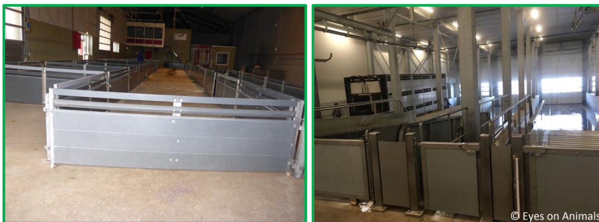
プラスチック製のゲートは金属製よりも騒音を低く抑えることができる。Meijerの輸出センター(写真左)とWestfortのと畜場(写真右)。
