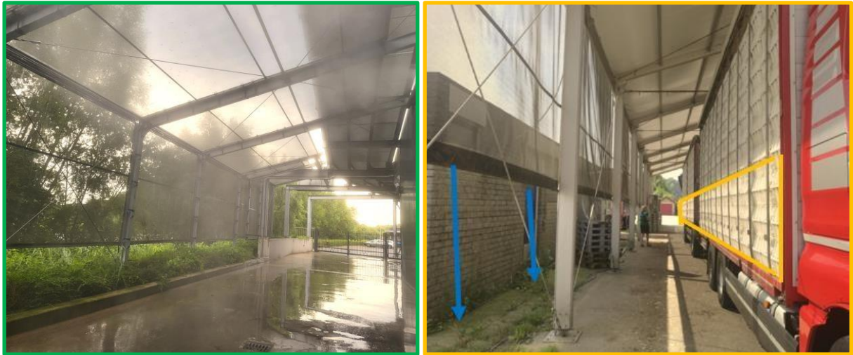
左: IJsselsteinにあるWestfort社のと畜場の側面の遮光ネット。右: このと畜場の遮光ネットは地面まで完全に閉じることができず(青い矢印)、そのためトラックの下の階に日が当たっている(オレンジ色の印)。
