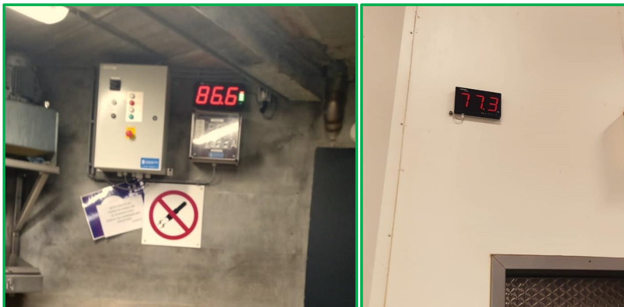
オランダのと畜場の騒音のレベルを示すモニター。左:積み下ろし場の騒音計。右:けい留所の騒音計。
