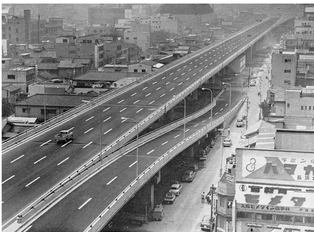
大 阪 1 号 線 高 架 橋
