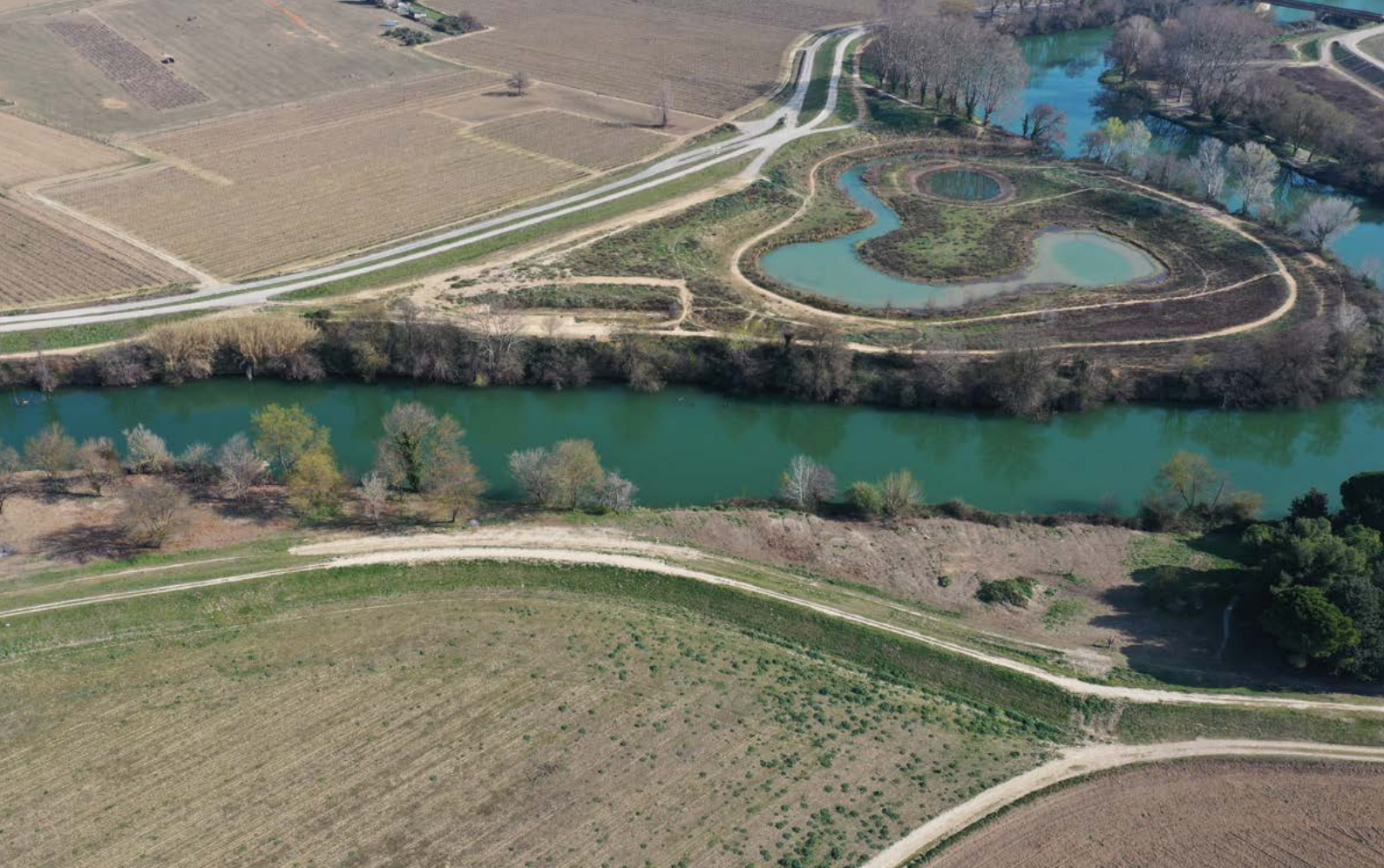
Aménagement d'une digue à Marsillargues
