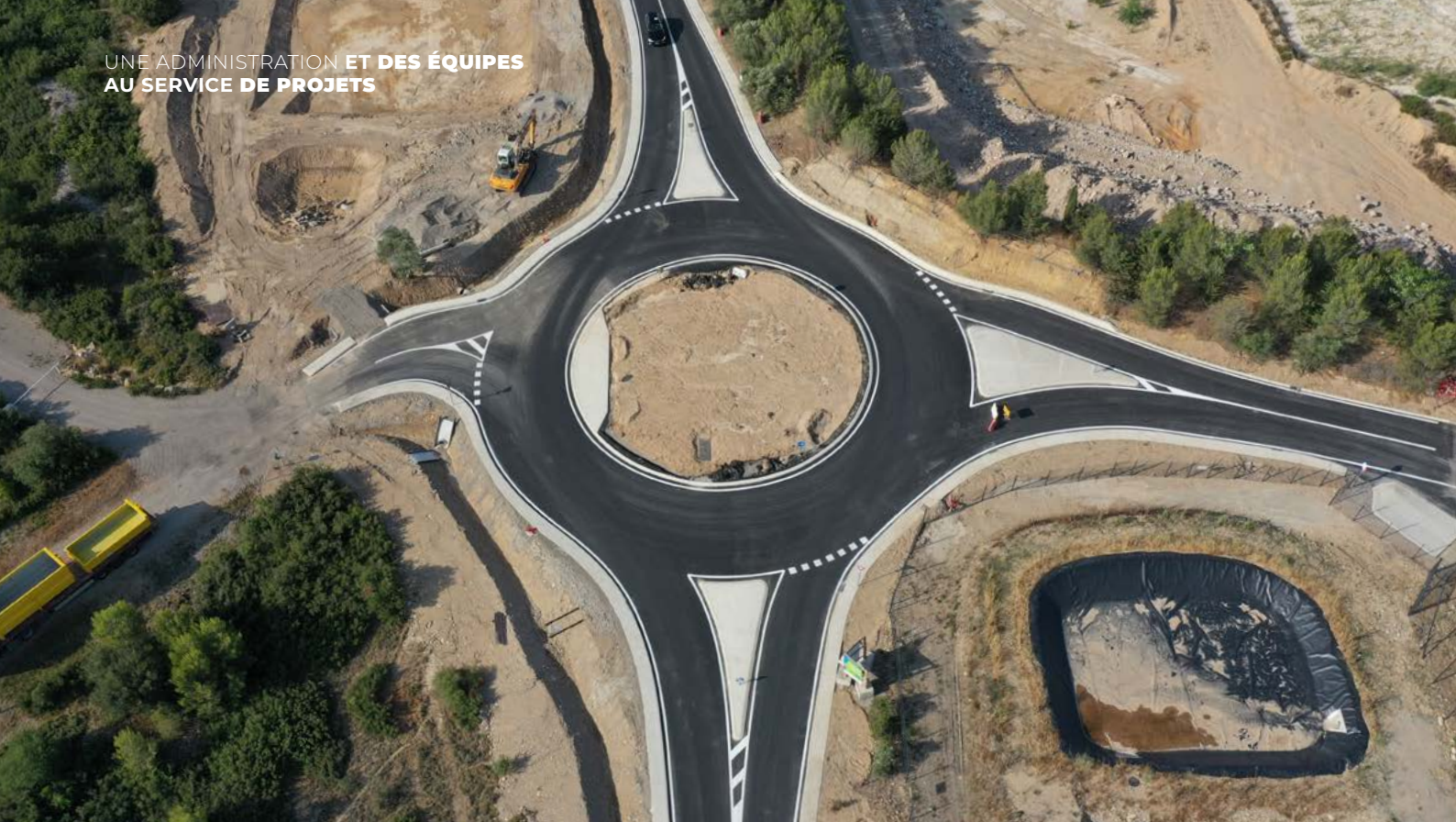
Construction d'un giratoire pour permettre l'accès à la déchèterie de Villetelle
