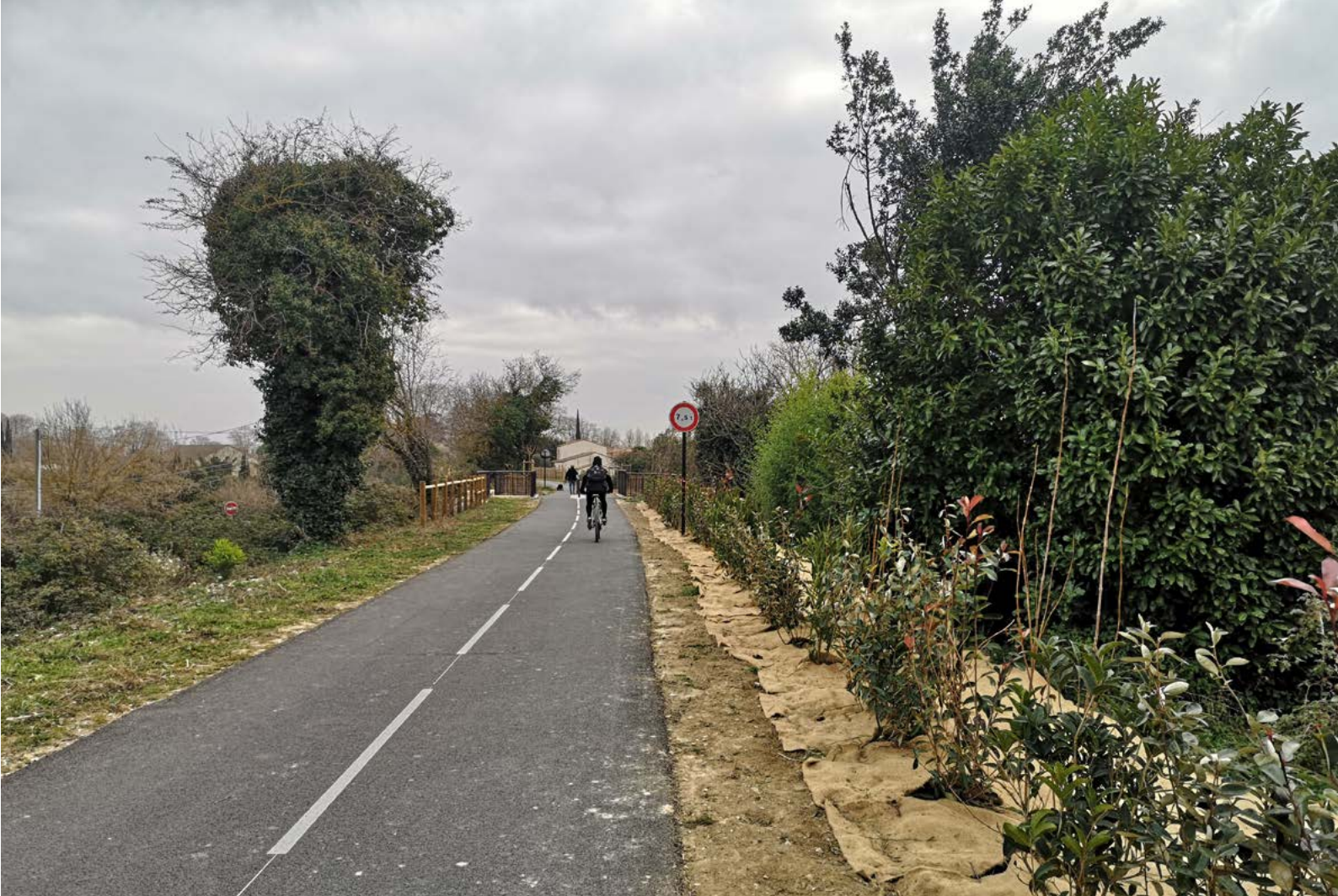
Aménagements paysagers de la voie verte Lunel - Marsillargues
