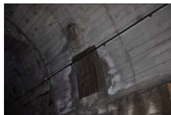
瀧溪隧道側壁導水
