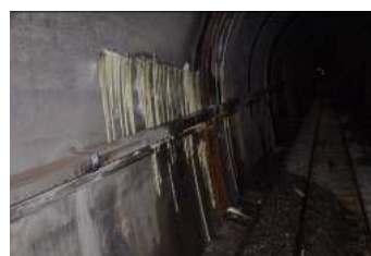
金崙隧道內滲水止漏
