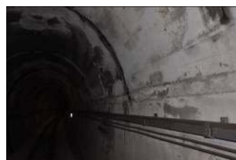
枋野三號隧道頂拱滲水
