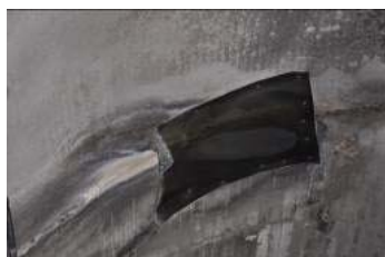
枋山一號隧道頂拱導水
