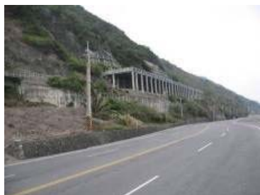
大武至金崙間邊坡
