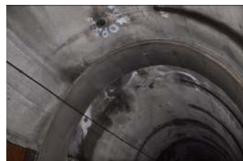
大武二號隧道頂拱導水
