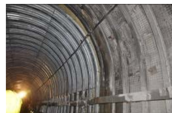
多良一號隧道鋼筋補強
