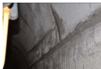
大武一號隧道側壁裂縫
