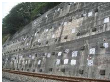
預力地錨擋牆護坡
