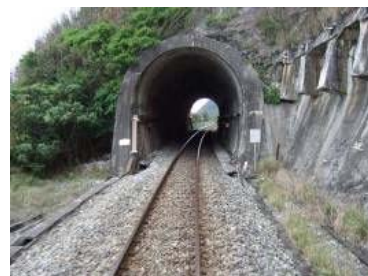
隧道口邊坡擋土
