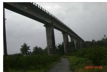
北太麻里溪橋
