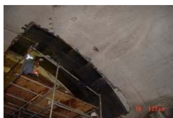
菩安隧道碳纖補強
