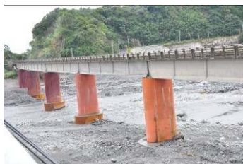
南太麻里溪橋
