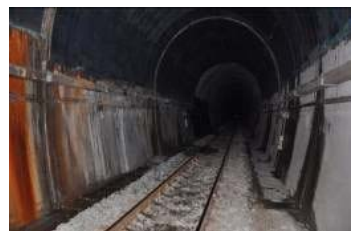
大武二號隧道碳纖補強
