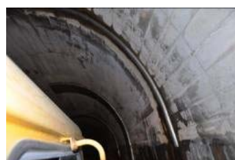
古莊四號隧道頂拱導水
