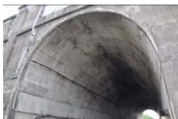
枋電一號隧道隧道頂拱
