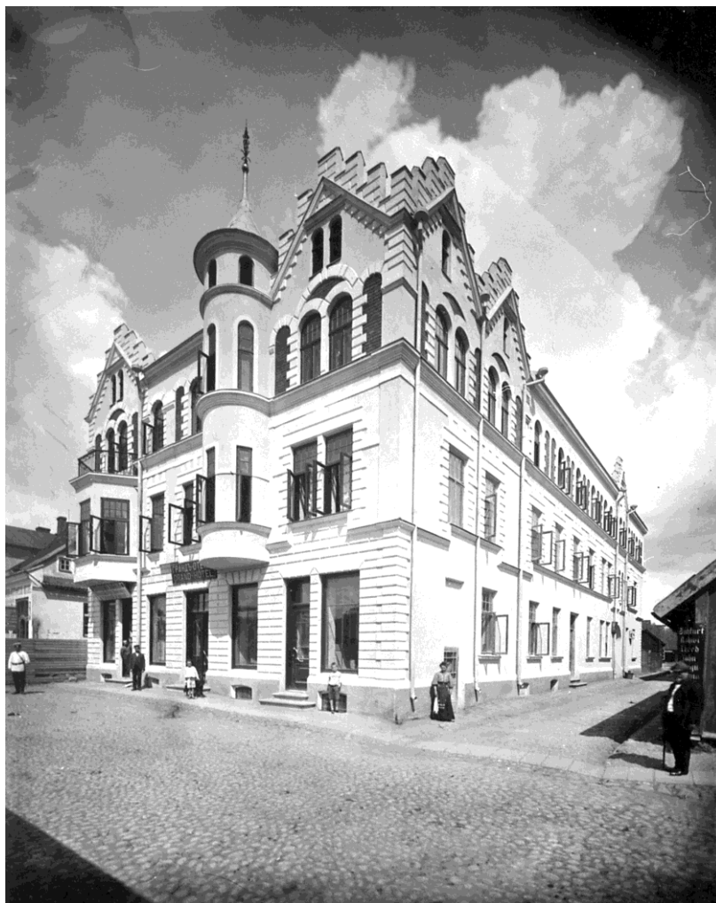
Vaade Hiire tänavale. Fotol on näha, kuidas kõnnitee graniitplaadid ei katke ka sõiduteel, vaid on selles osas sõiduteega võrdsel tasapinnal.
