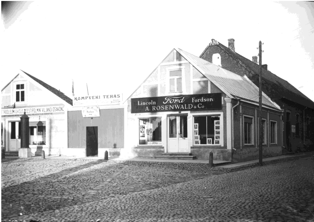
Heinaturg ehk väike turg Kauba ja Väike-Turu tänava ristumiskohal. Sõidutee ja turuplats kaetud munakivisillutisega, kõnniteed graniitplaatidega. Fotel näha ka omaaegne kuulutustetulp ning graniitpostid kõnnitee ääres.
