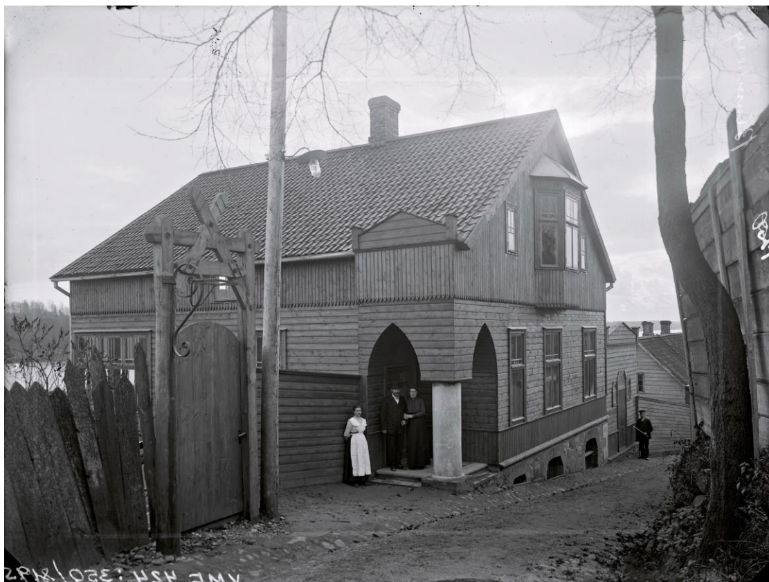
Pikk tn 39, G. Blumbergile kuulunud villa. Fotol näha tüüpilised plankaiad ning samuti valgusti, mis on kinnitatud puitposti külge
