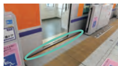
ホーム先端部の改修
