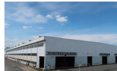
南栗橋車両管区工場棟
