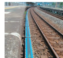
転落支障報知装置（マットスイッチ）
