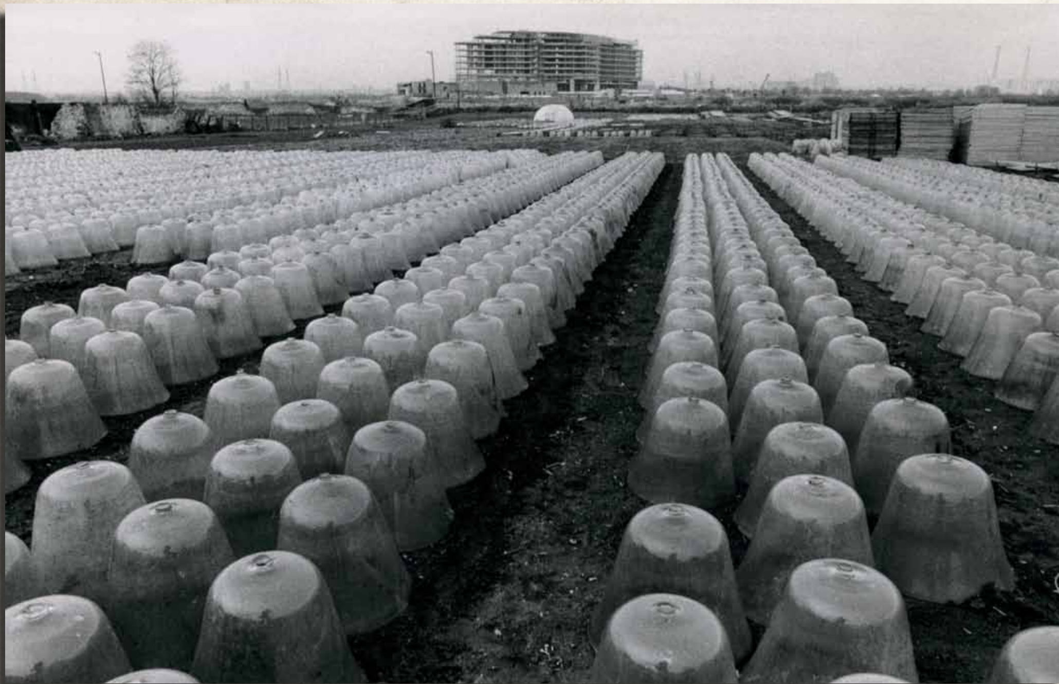
Cloches des maraîchers devant la Préfecture en construction, 1968-1970 10Fi60, Fonds SEMAEC, Archives municipales
