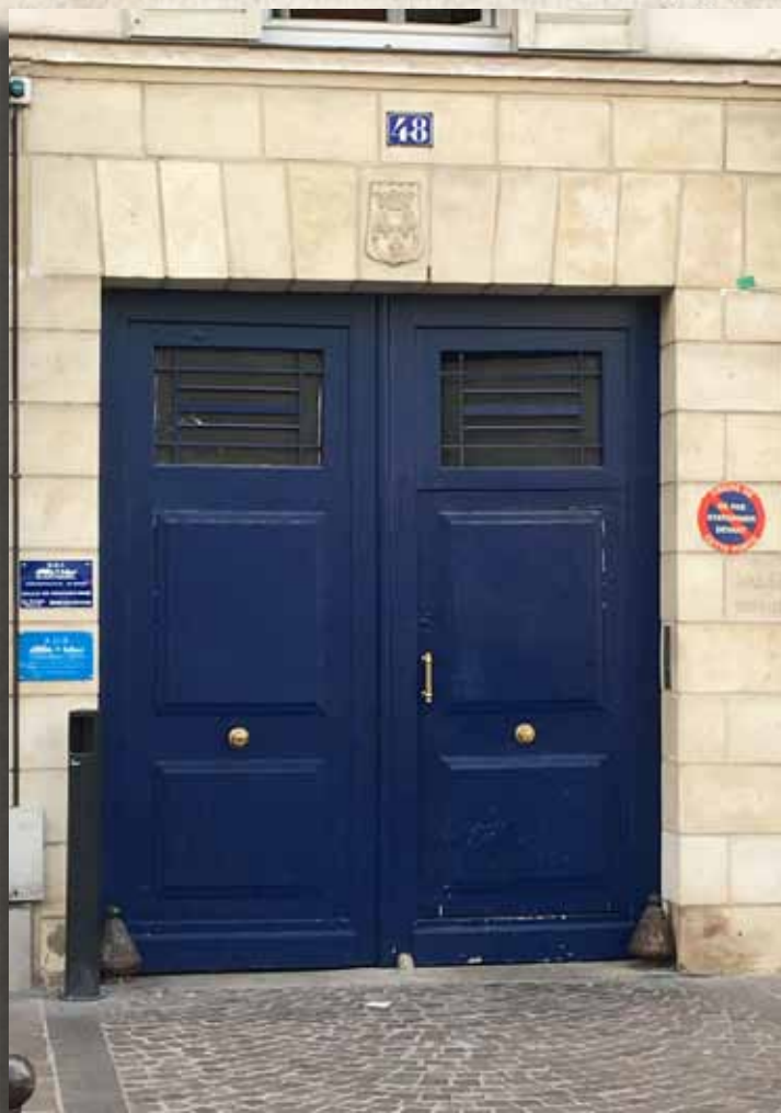
Porte et linteau, 48 rue du Général Leclerc, 3 juillet 2018 Archives municipales
