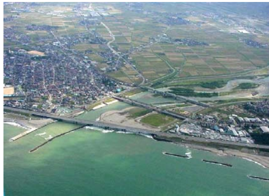
【現況写真】(第九管区海上保安本部)
