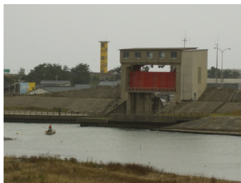
【美川漁港水門】
