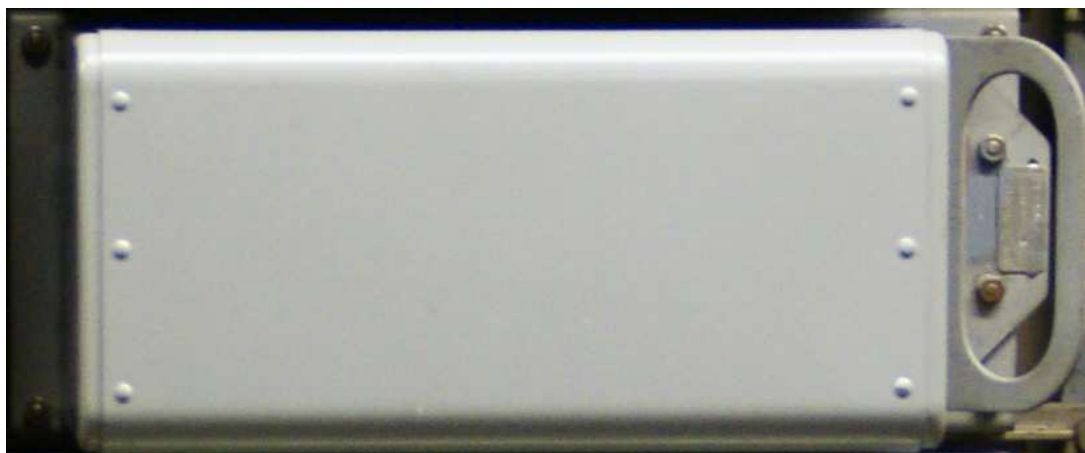
Relaiskoffer des Systems 50, die in der A-Anlage als Gehäuse für die Anschalttechnik dienten
