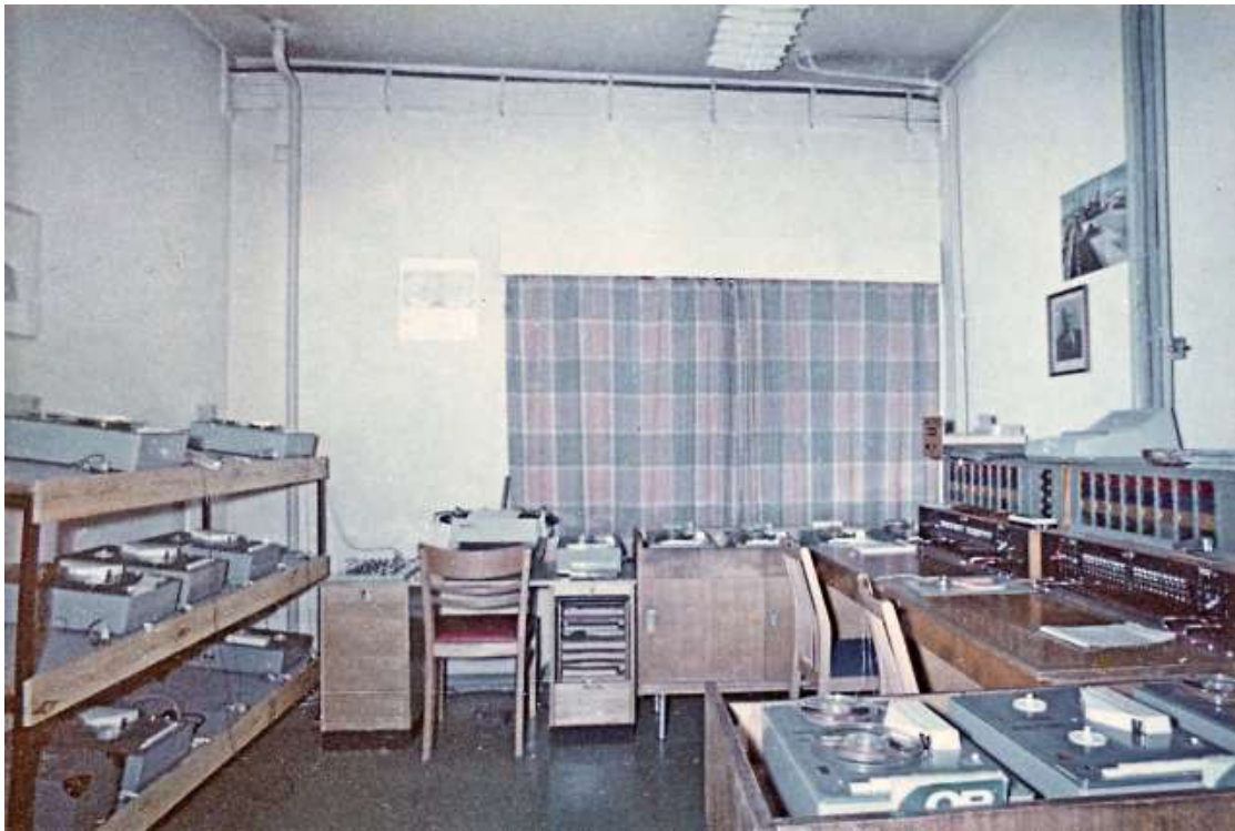
A-Anlage mit altem Bedienpult in Karl-Marx-Stadt. Am Bedienpult wurden die im Gesprächszustand befindlichen Leitungen signalisiert, manuell zur Aufnahme mit einem Tonbandgerät verbunden und dieses gestartet.
