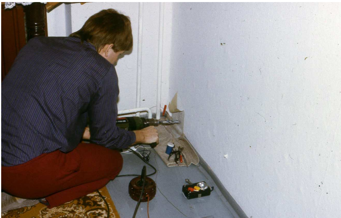
Ein Loch wird durch die Wand gebohrt.
